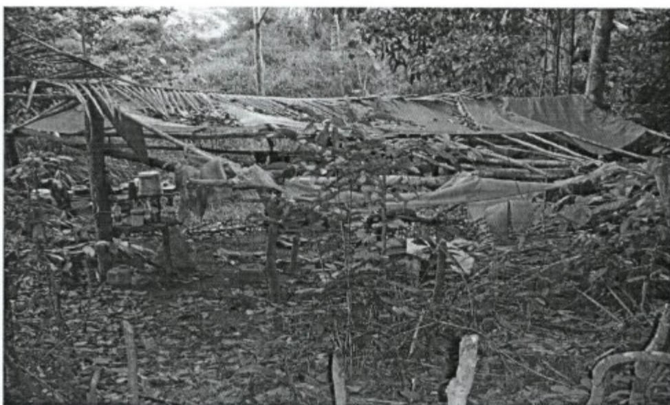
Foto 19 – Visão da cobertura do barraco.
