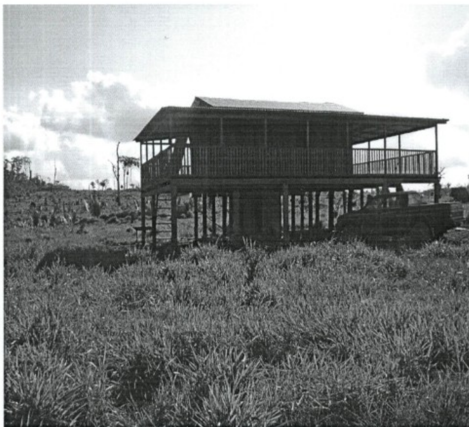
Foto 08 – casa de madeira que ficava próxima ao barraco mas que não possuía banheiro e água encanada.
