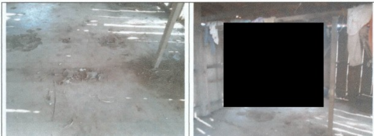
As imagens demonstram que o piso estava completamente deteriorado, cheio de buracos e de terra.
