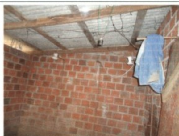
Instalações elétricas do banheiro: Risco grave e iminente de choques elétricos.
