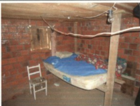
Cama improvisada, tampa da janela que não oferece total vedação e instalações elétricas precárias.
