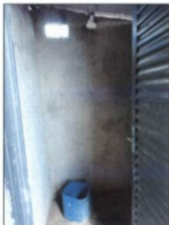
Cômodo onde ficava o chuveiro com o balde utilizado para manter a água a ser usada nos banhos, visto que o chuveiro não dispunha de água.
