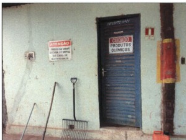
Porta de acesso de um dos cômodos (situado à esquerda) utilizados para armazenamento de agrotóxicos – placa com dizeres genéricos e sem símbolos de perigo.
