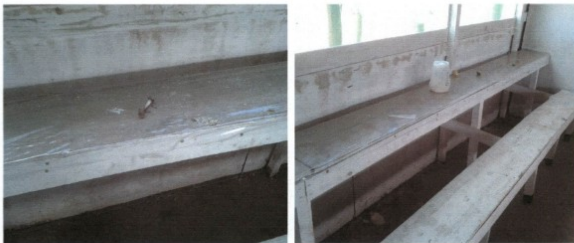
O refeitório do canteiro de obras não era mantido limpo
