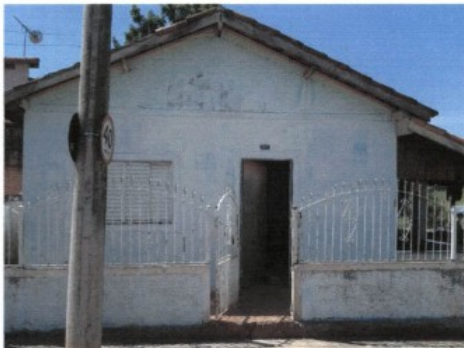
Vista externa do primeiro alojamento
