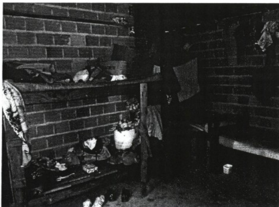
Visão interna do alojamento: A ausência de armários no alojamento exigia que os trabalhadores guardassem seus pertences espalhados por todo o cômodo.
