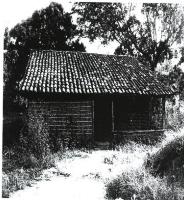
Vista frontal do alojamento
