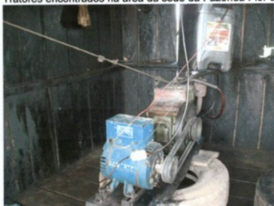
Geradores de energia com as partes vivas desprotegidas. Ambos foram interditados.
