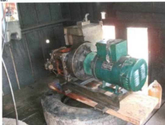
Geradores de energia com as partes vivas desprotegidas. Ambos foram interditados.
