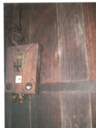
Chave tipo faca que acionava o gerador.
