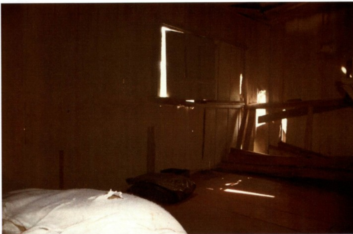
vista interna de um dos quartos do alojamento
