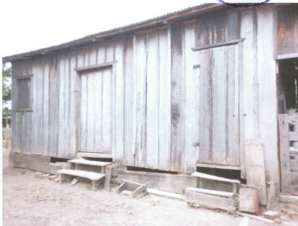
Local de armazenamento de agrotóxico em que a porta está sem trava e há frestas na parte superior
