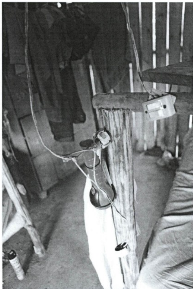
Foto 22: gambiarra na fiação elétrica do 2º alojamento
