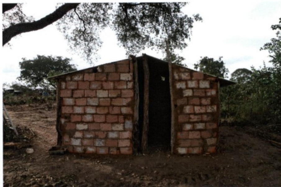
Foto 02: Edificação em construção.
