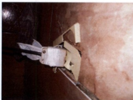
No banheiro, tomada com risco de choque elétrico. Banheiro e vaso sanitário, sem box, criando ambiente molhado e sujo.
