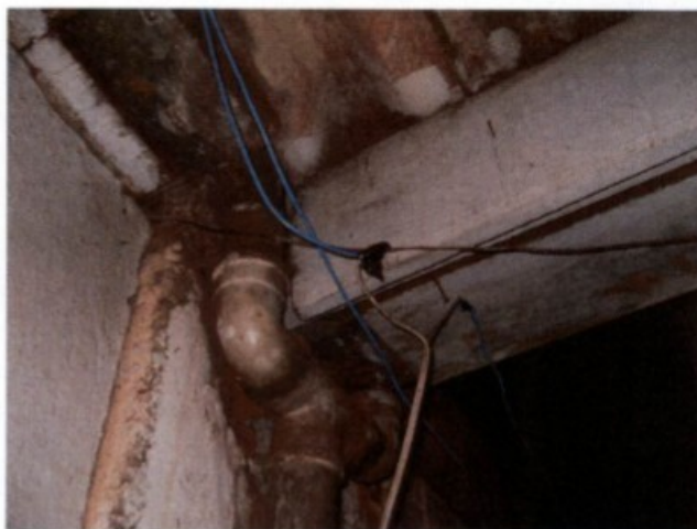
Precariedade e improvisação das instalações elétricas no alojamento do antigo Hotel São Francisco, em Engenheiro Beltrão - PR
