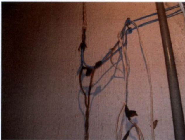
Precariedade e improvisação das instalações elétricas no alojamento do antigo Hotel São Francisco, em Engenheiro Beltrão - PR
