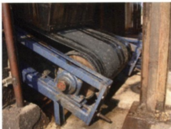
Foto 23 – Esteira rápida de borracha sem proteção na correia e no tambor
