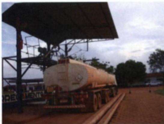
Fotos 18 e 19 - Passarelas sem rodapé – Escadas tipo marinheiro com espaçamento entre as gaiolas e entre as barras maior que o exigido pela NR-12
