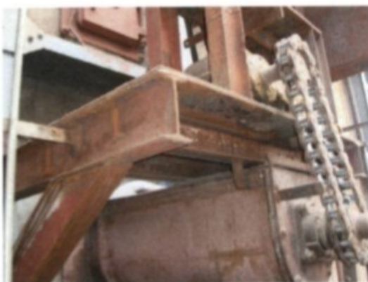
Foto 15 - Correntes e engrenagens das transmissões de força expostas
