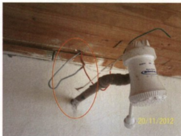
Foto 33: instalação elétrica de um dos chuveiros em que se verifica a existência de partes vivas
