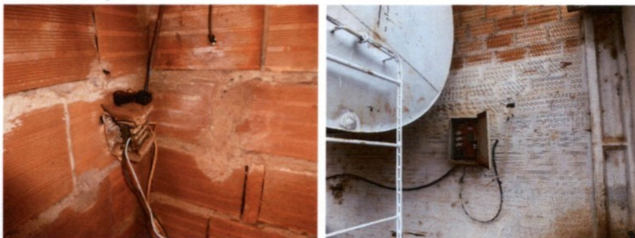
Fotos 13 e 14 – Instalações elétricas com risco de choque: foto eq. na Fazenda Formoso e dir. na Fazenda Pindaíba.
