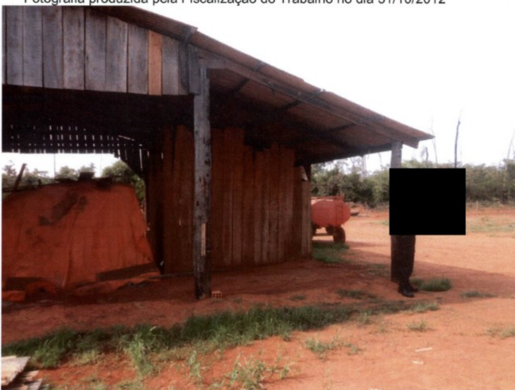
Remoção de lona preta que cercava “dormitório” utilizado pelos trabalhadores
