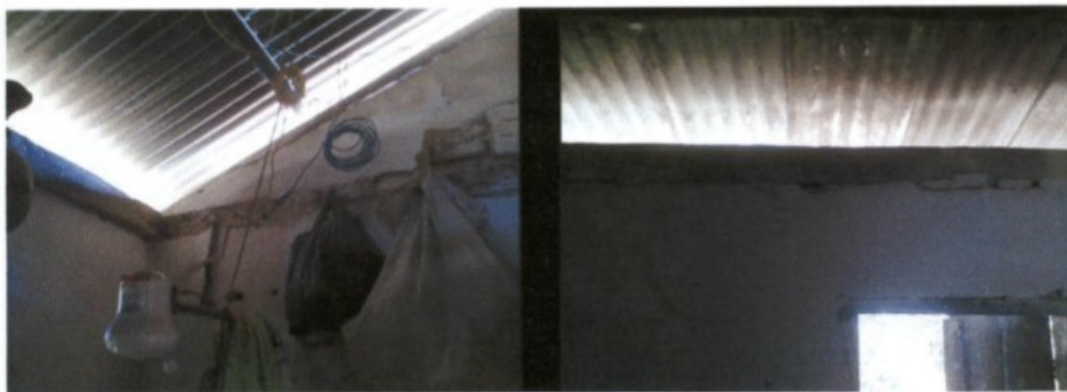
Frestas entre paredes e telhado
