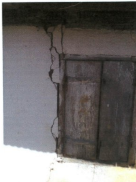
Rachaduras entre paredes e esquadrias
