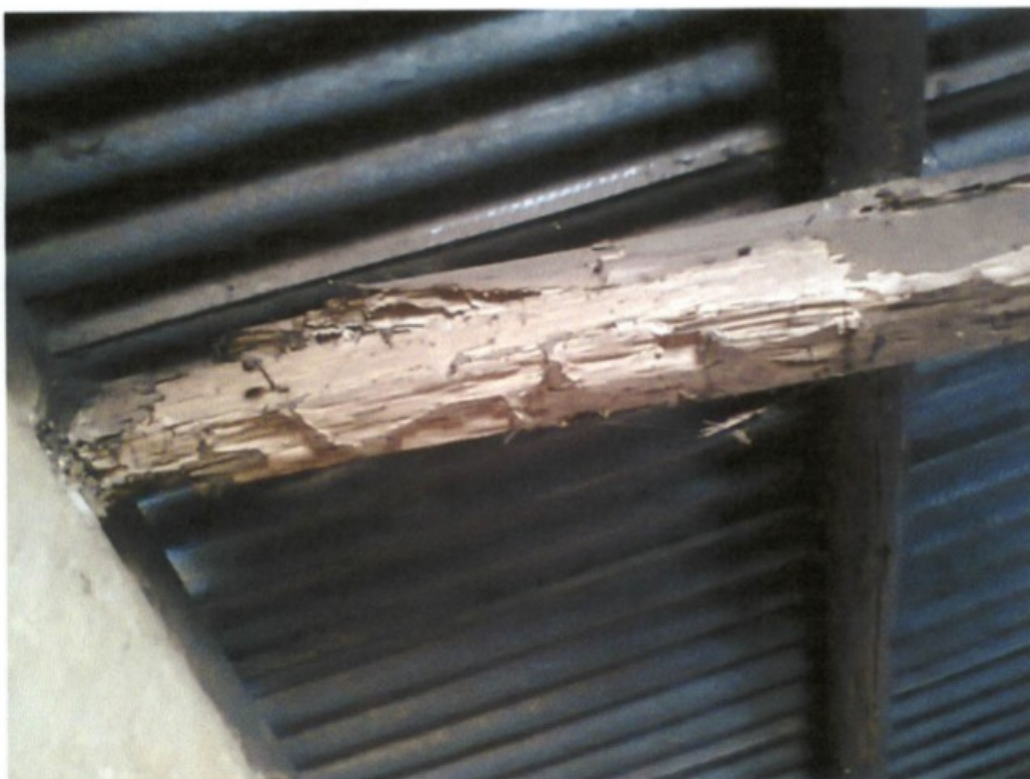
Caibros de sustentação do telhado avariados
