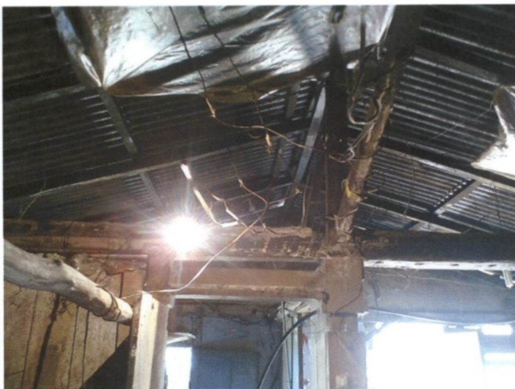
Fiação elétrica exposta - riscos de choque elétrico e de incêndio
