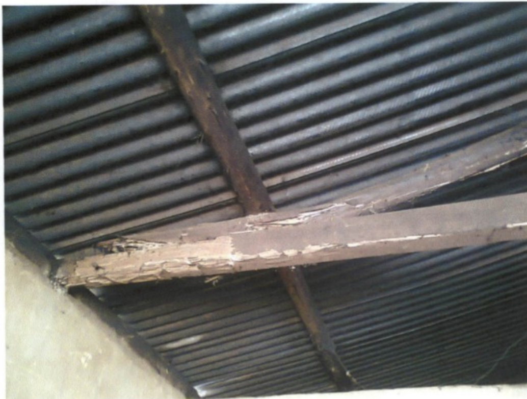
Caibros de sustentação do telhado avariados
