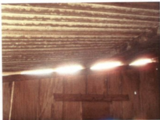
Frestas nas paredes e entre a cobertura e as paredes permitiam a passagem da água da chuva
