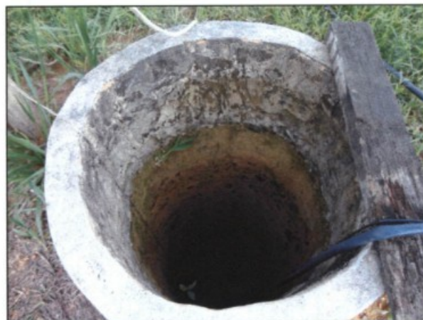
Poço não artesiano sem vedação do qual provinha a água utilizada nas baterias de fornos e também para higiene pessoal e preparo de alimentos dos trabalhadores alojados na edificação de madeira.
