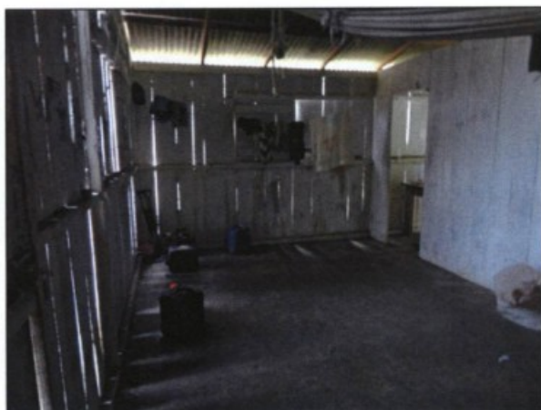
Vista parcial do interior da edificação de madeira utilizada como alojamento: vedação deficiente, condições precárias de conservação e higiene, sem armários para guarda dos pertences.
