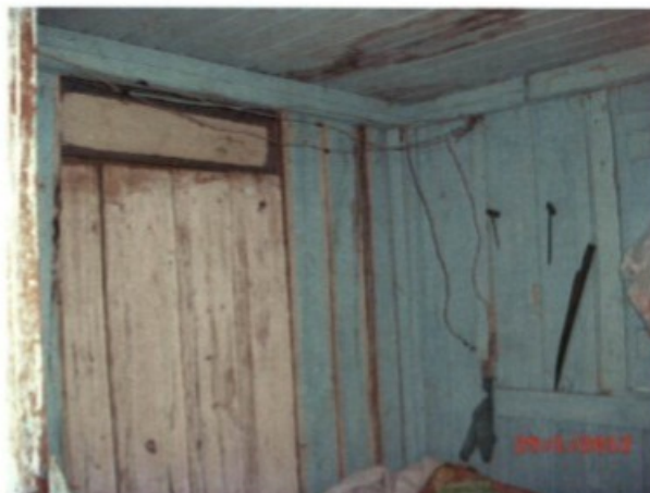
Instalações elétricas no alojamento feitas através de gambiarras.
