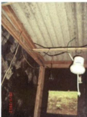
Instalações elétricas no alojamento feitas através de gambiarras.
