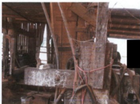
Fiação elétrica exposta, fora de eletrodutos
