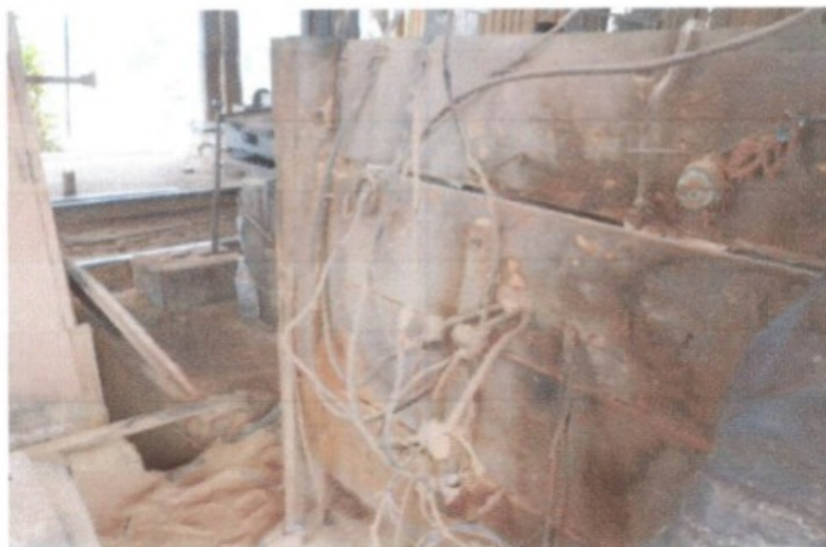
Foto de fiação sem prevenção existente no local
