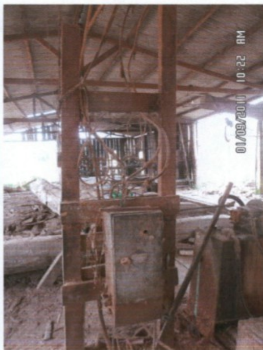
Fiações elétricas expostas e fora de eletrodutos
