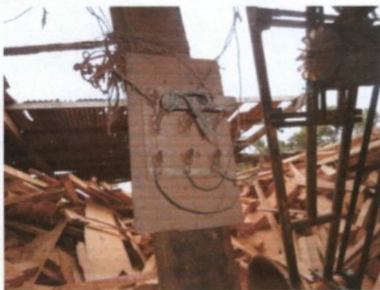
Fiações elétricas expostas e fora de eletrodutos
