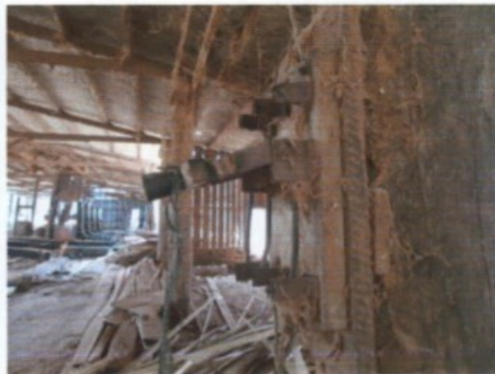
Chaves tipo faca nos circuitos elétricos
