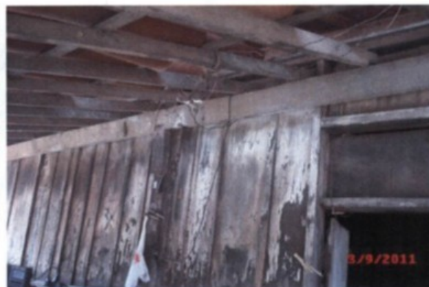
Foto 14 – Teto do barraco usado como alojamento, com fiação elétrica exposta.
