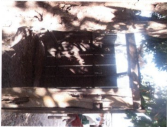
Fossa negra em desconformidade com a Norma Cogente.
