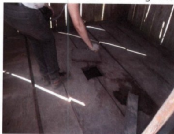
Fossa negra em desconformidade com a Norma Cogente.
