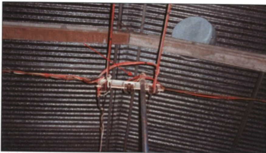
Fiação exposta no interior do alojamento
