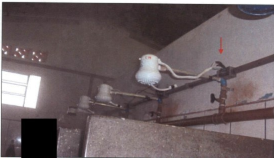
Fita isolante no fio exposto do chuveiro elétrico
