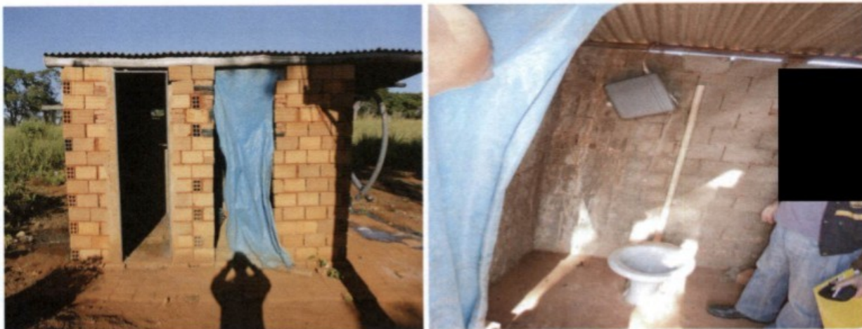
Fotos 23 e 24 – instalação sanitária: sem porta, sem água, sem uso.
