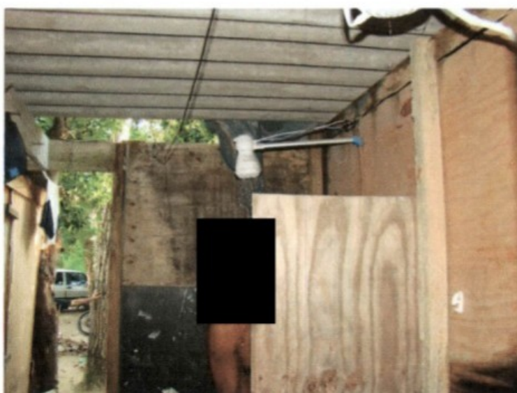
Local para banho sem porta, com cobertura incompleta e instalações elétricas improvisadas.
