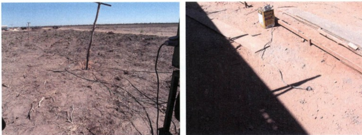
Fios elétricos sem a proteção adequada.
