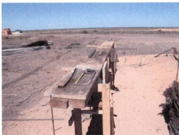
Bancada de armação sem cobertura.
