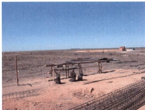
Bancada de armação sem cobertura.
