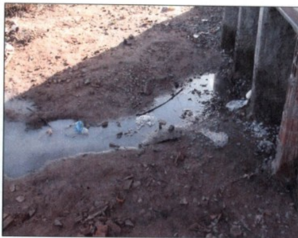
Vista da situação do tanque instalado, com esgoto escorrendo pelo chão.
