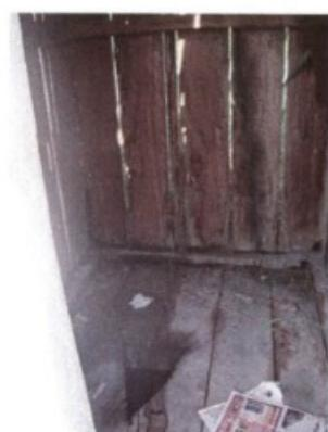
Havia muitas frestas entre as peças de madeira, o que não garantia um isolamento adequado entre o interior da instalação e ambiente externo. A instalação era guarnecida apenas de porta.
