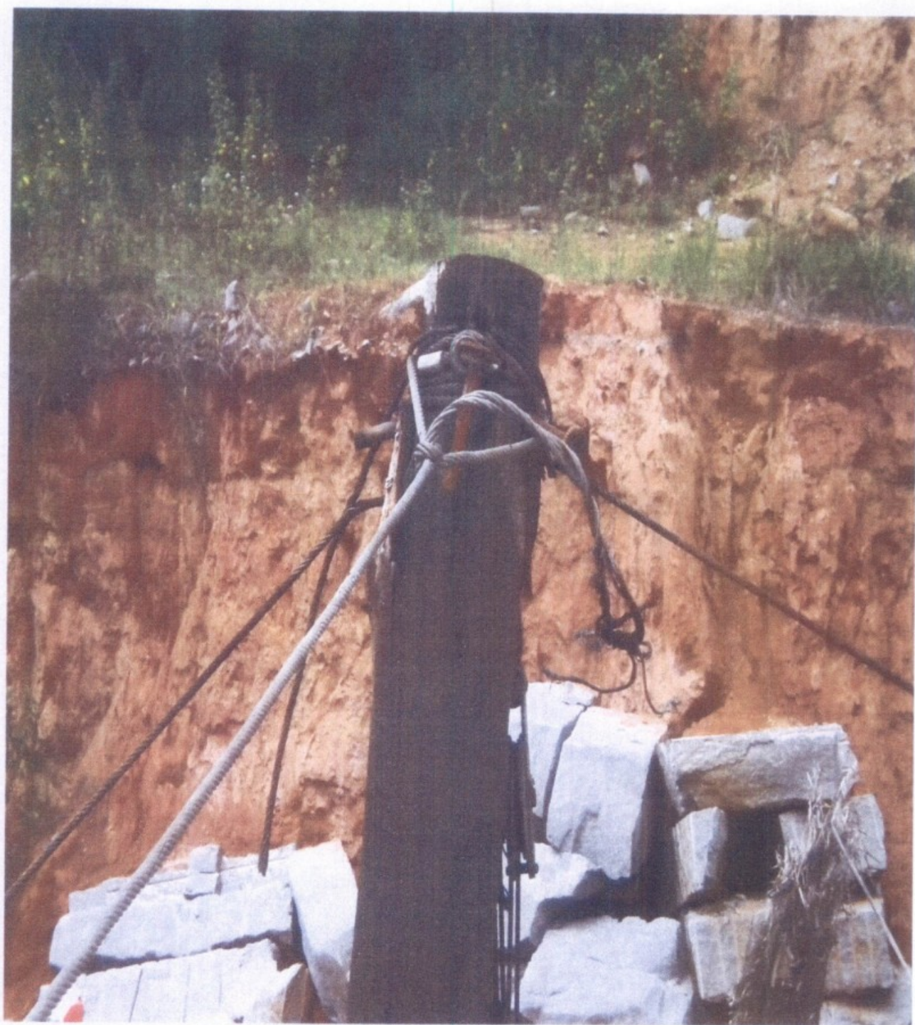
Condições de fixação dos cabos ao tronco de madeira
