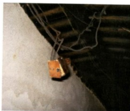
Fiação elétrica exposta – risco de choque elétrico e incêndio.
