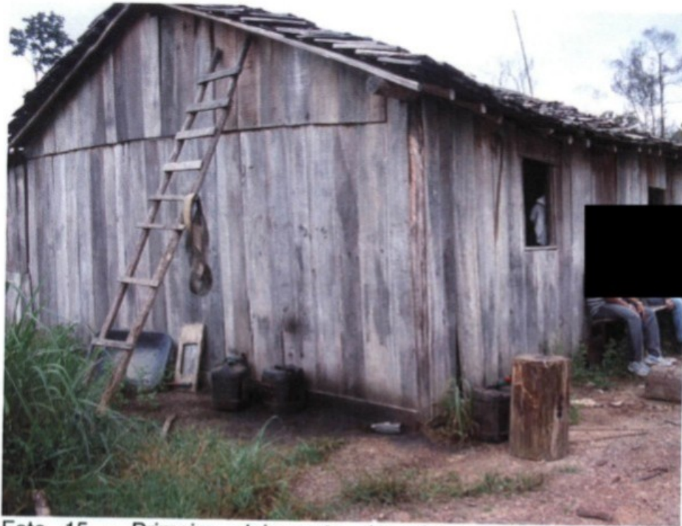
Foto 15 - Primeiro alojamento do núcleo I (galões reutilizados para armazenamento de água destinada ao consumo dos trabalhadores).
