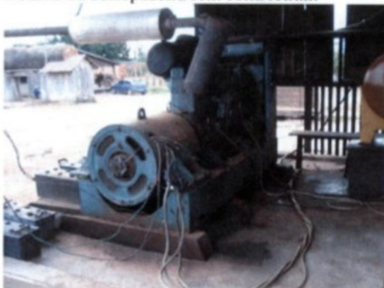
Gerador de energia elétrica instalado em local que não possui isolamento ou delimitação de área.
