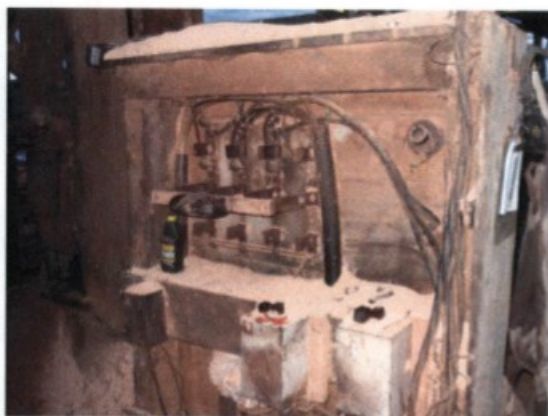
Chave tipo faca para acionamento da Serra-fita.
