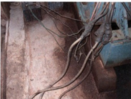
Conexões elétricas inadequadas no gerador.
