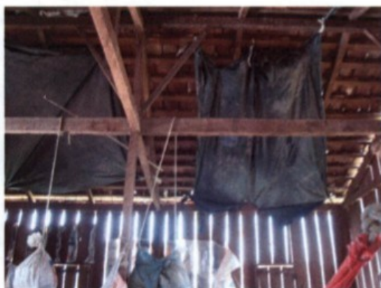
Lona plástica colocada pelos obreiros no teto, a fim de minimizar o gotejamento de água durante as chuvas.
