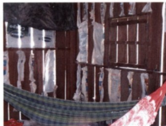
Vista do interior do depósito. Sacos plásticos e de nylon eram utilizados na tentativa de vedar as frestas entre as tábuas nas laterais do depósito.
