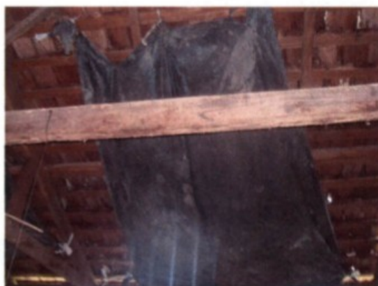
Lona plástica colocada pelos obreiros no teto, a fim de minimizar o gotejamento de água durante as chuvas.
