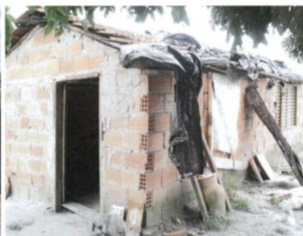
Fotos 16 e 17 – Tetos das moradias construídos com telhas antigas e lonas plásticas.
