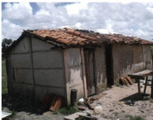
Fotos 16 e 17 – Tetos das moradias construídos com telhas antigas e lonas plásticas.
