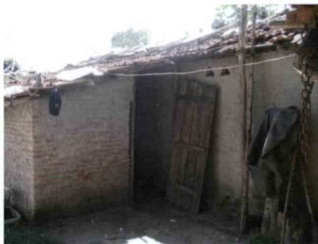
Fotos 14 e 15 – paredes sem janelas, prejudicando a ventilação e deixando o ambiente mais quente.
