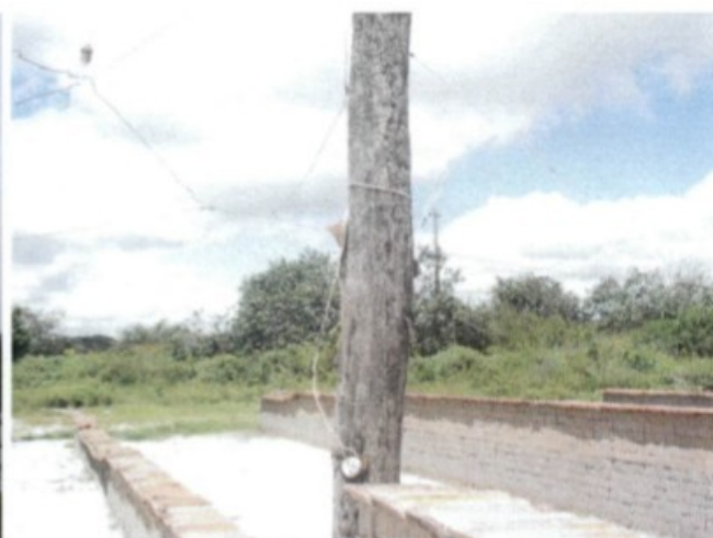
Fotos 23 e 24 – instalações elétricas irregulares, componentes expostos às intempéries e com risco de choques elétricos.
