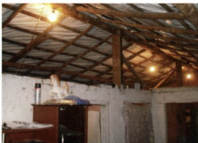
Fotos 16 e 17 – Tetos cobertos com lonas plásticas, gerando desconforto e riscos de incêndios.
