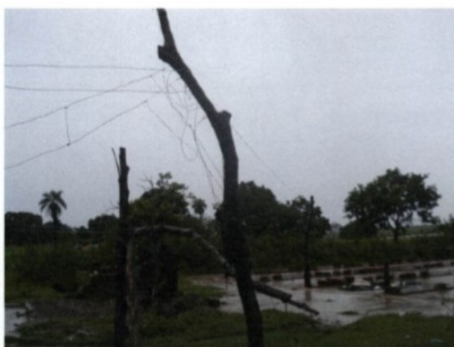
Fotos 23 e 24 – instalações elétricas irregulares, componentes expostos às intempéries e com risco de choques elétricos.
