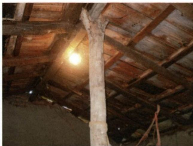
Fotos 12 e 13 – Teto escorado com tronco de madeira e parede já reformada após rachaduras e inclinação.
