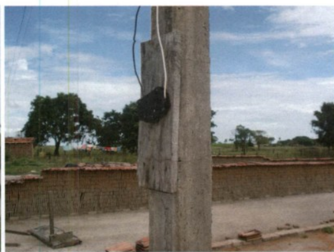
Fotos 24 e 25: redes instaladas de forma inadequadas e componentes elétricos expostos às intempéries e com riscos de choque.
