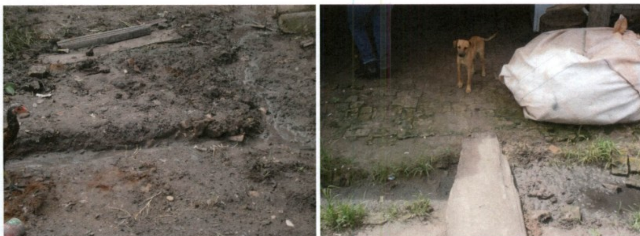
Fotos 22 e 23: esgoto a céu aberto: as águas servidas não eram canalizadas.
