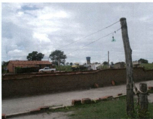
Fotos 24 e 25: redes instaladas de forma inadequadas e componentes elétricos expostos às intempéries e com riscos de choque.
