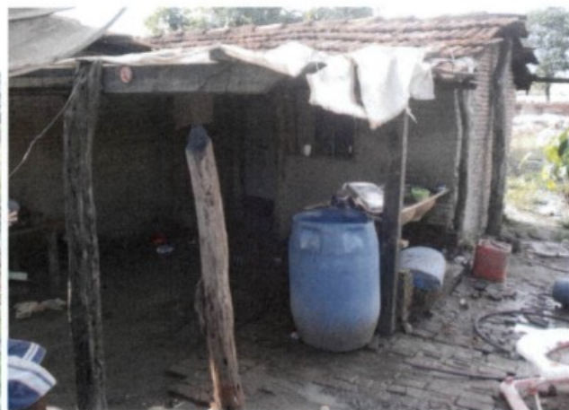
Fotos 16 e 17: Barracos com paredes escoradas, com sérios riscos de desabamento. Veja que já houve queda de parede.
