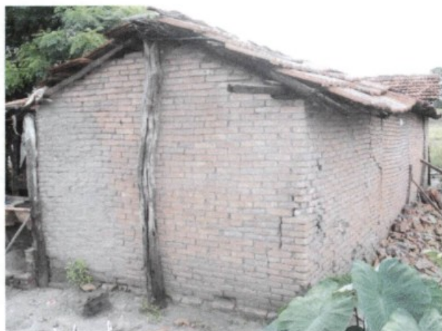
Fotos 16 e 17: Barracos com paredes escoradas, com sérios riscos de desabamento. Veja que já houve queda de parede.
