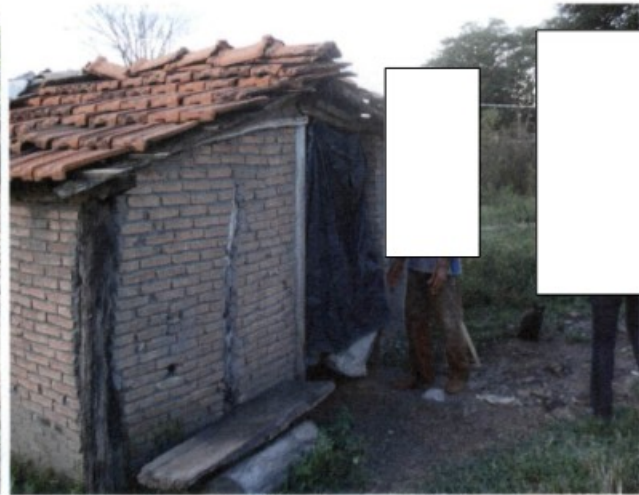
Fotos 18 e 19: Barracos com paredes escoradas, com sérios riscos de desabamento. Veja que o da direita nem porta tem.
