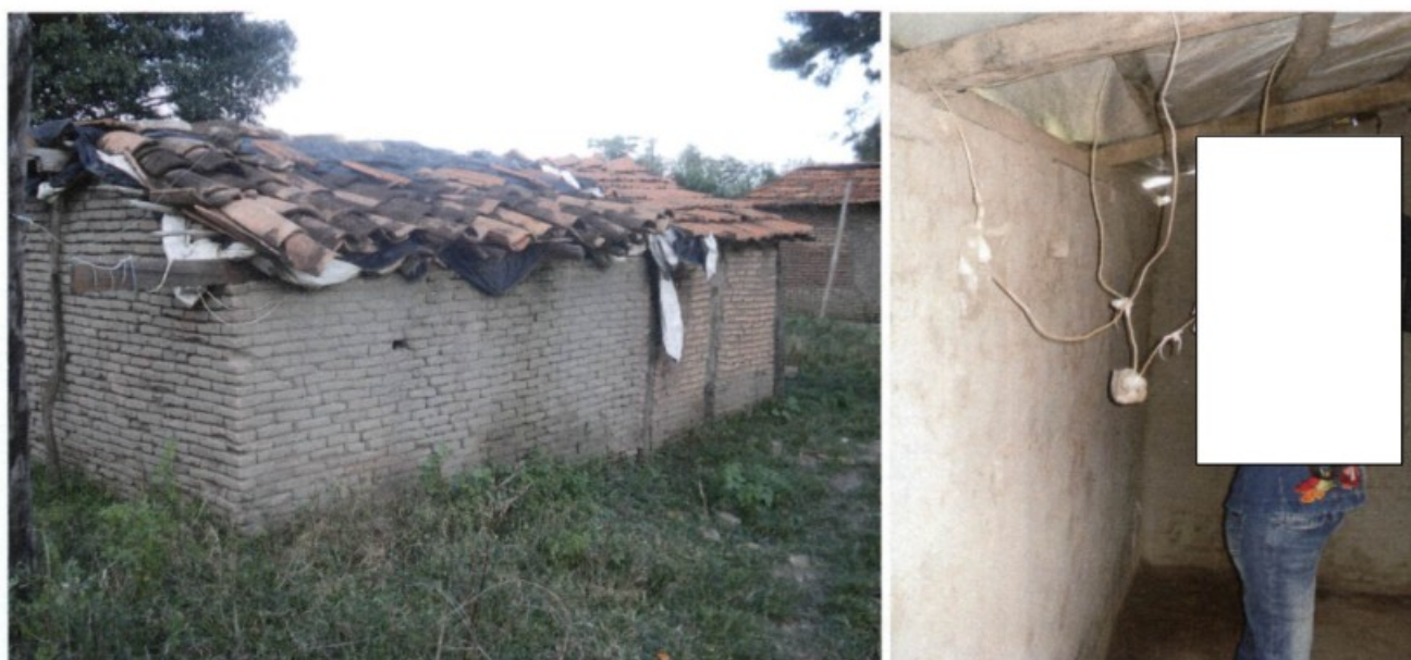
Fotos 22 a 25: Telhados cobertos com lona para proteger contra chuvas, gerando calor e risco de incêndios.
