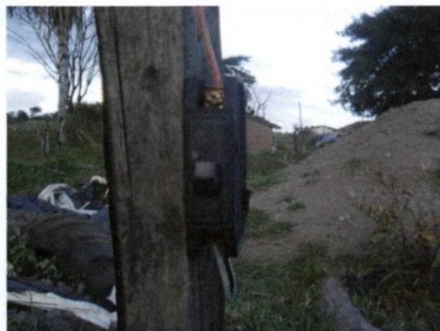
Fotos 46 e 47: Rede elétrica instalada em árvores e disjuntores com partes vivas expostas, com riscos de choques.
