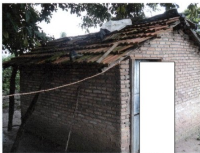
Fotos 18 e 19: Barracos com paredes escoradas, com sérios riscos de desabamento. Veja que o da direita nem porta tem.
