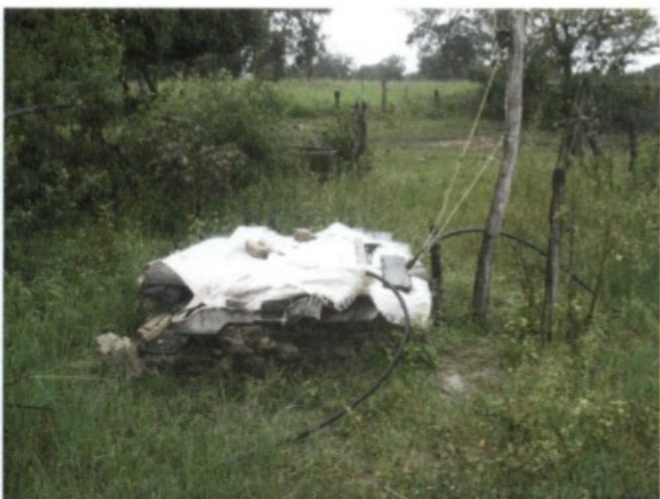
Foto 22 – poço fechado de forma inadequada, permitindo entrada de insetos e outros animais.
