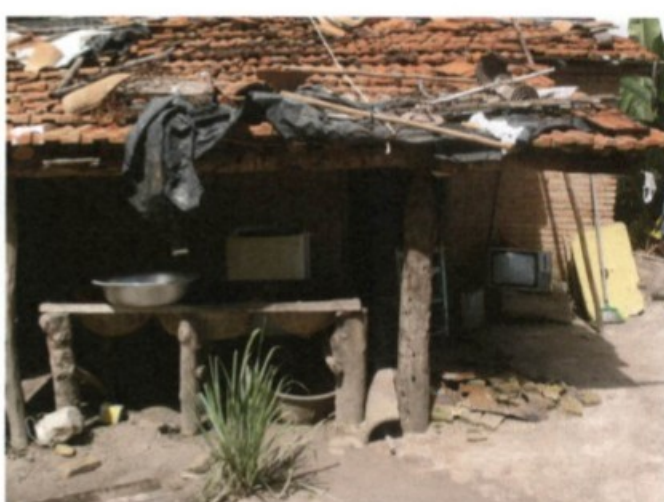
Fotos 20 e 21 – barracos com telhados construídos com telhas antigas, tendo que ser recobertos com lonas plásticas.
