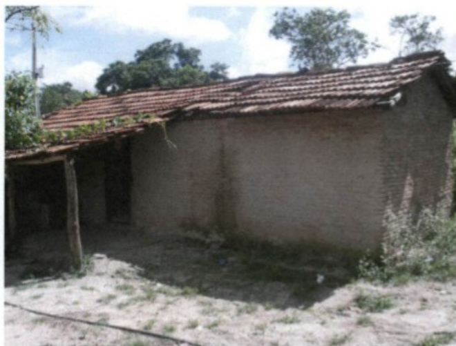
Fotos 18 e 19 – barracos com paredes sem janelas, prejudicando a ventilação e deixando o ambiente ainda mais quente.
