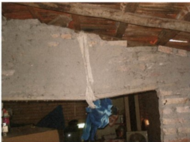
Fotos 14 e 15 – barracos com paredes tortas e escoradas, com sérios riscos de desabamento.
