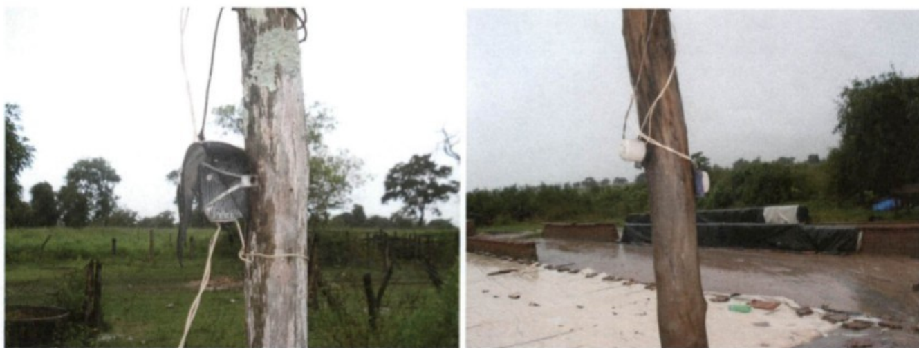
Fotos 34 e 35 – instalações elétricas inadequadas, com componentes expostos às intempéries e com sérios riscos de choques.
