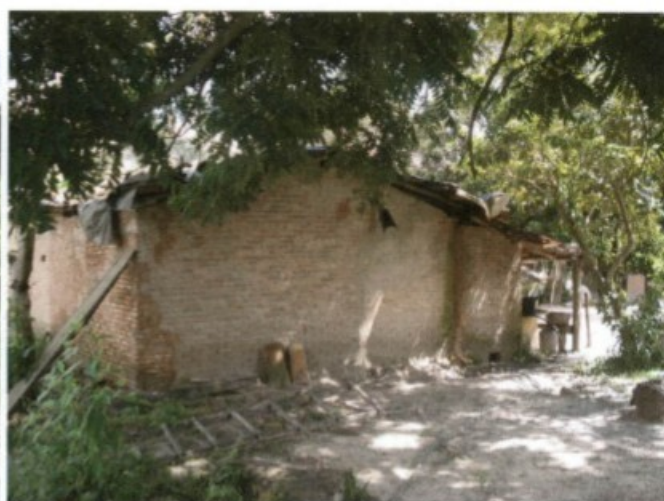
Fotos 18 e 19 – barracos com paredes sem janelas, prejudicando a ventilação e deixando o ambiente ainda mais quente.
