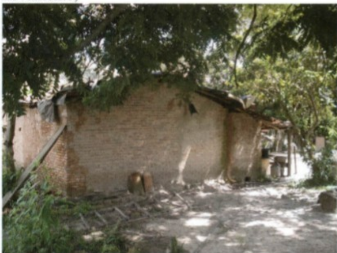
Fotos 14 e 15 – barracos com paredes tortas e escoradas, com sérios riscos de desabamento.
