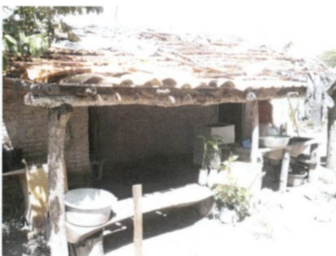
Fotos 20 e 21 – barracos com telhados construídos com telhas antigas, tendo que ser recobertos com lonas plásticas.
