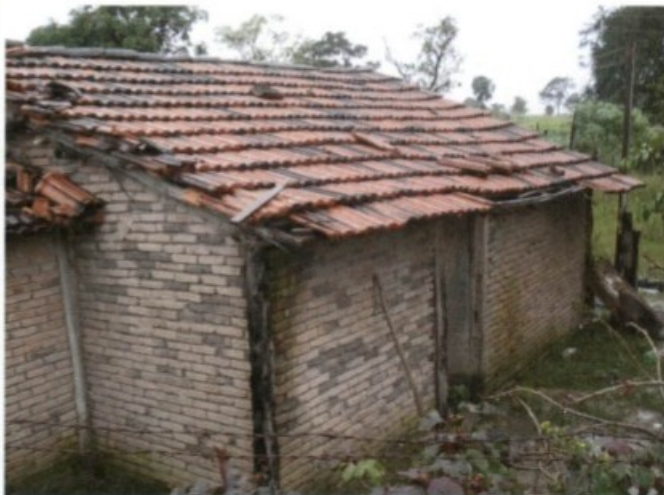
Fotos 16 e 17 – barracos velhos com paredes sem reboco e sem pintura.
