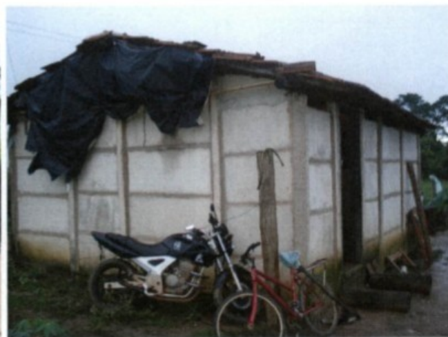
Fotos 18 e 19– Parte dos telhados tinha que ser cobertos com plásticos, pois o telhado não impedia a entrada das chuvas.
