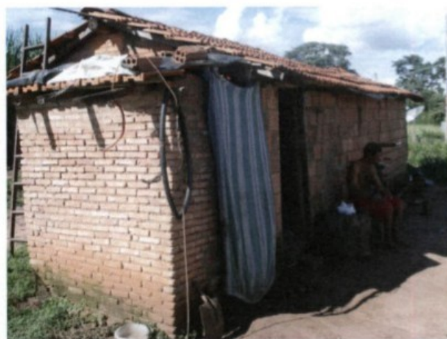
Fotos 18 e 19– Parte dos telhados tinha que ser cobertos com plásticos, pois o telhado não impedia a entrada das chuvas.
