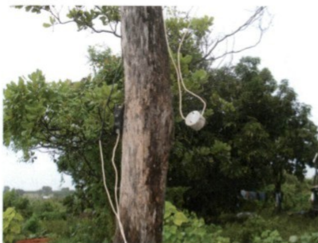
Fotos 32 e 33 – Redes e componentes elétricos instalados de forma inadequada, com partes vivas expostas.
