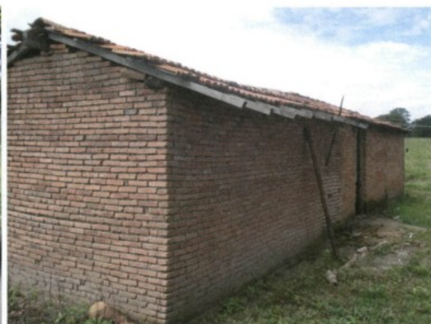
Fotos 14 e 15: barracos com paredes escoradas, com riscos de desmoronamento.
