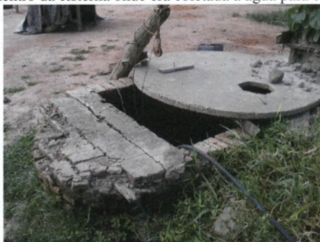
Fotos 20 e 21: cisternas sem fechamento adequado, permitindo a contaminação da água e riscos de acidentes
