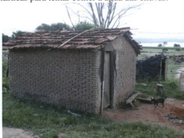
Fotos 18 e 19: telhados construídos com telhas antigas e pedaços de plásticos para conter as águas das chuvas.
