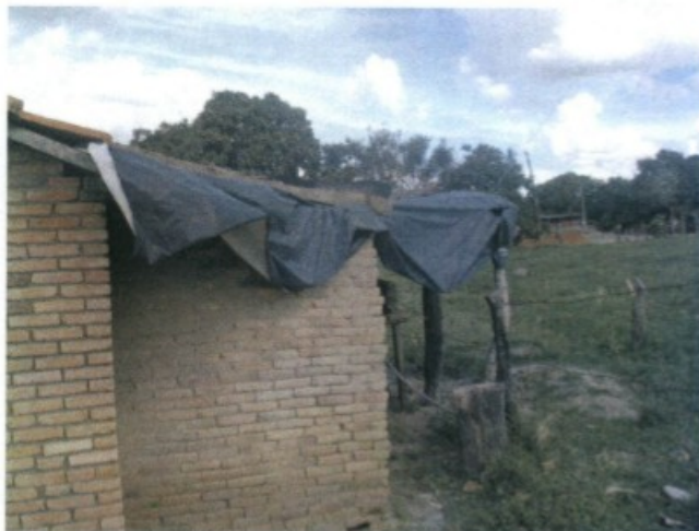
Fotos 16 e 17 – telhado construído com telhas antigas e com lonas plásticas.
