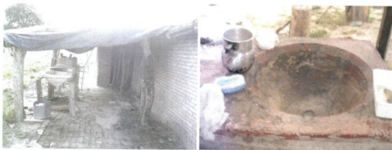
Fotos 24 e 25 – tanques quebrados e sem encanação das águas servidas.
