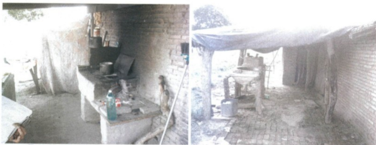
Fotos 22 e 23 – pisos construídos somente com tijolos assentados, impossibilitando a limpeza e higiene.
