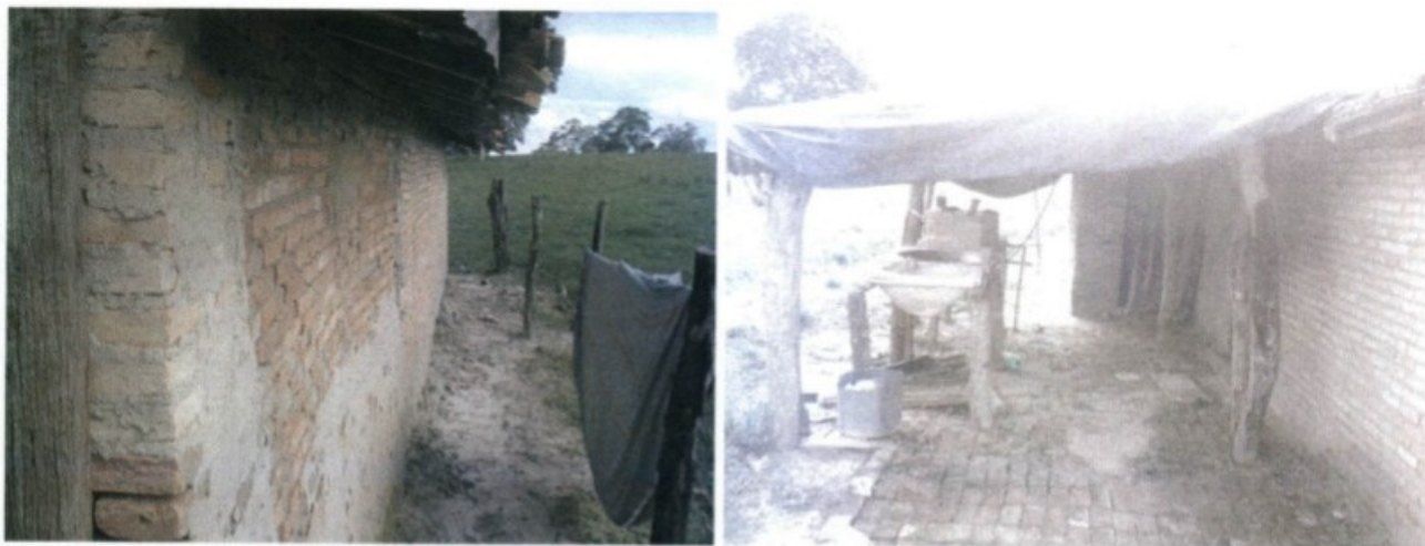
Fotos 12 e 13 – paredes tortas e telhado escorado de forma improvisada.
