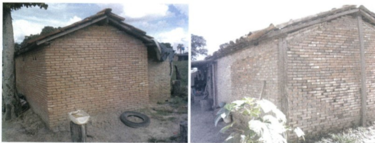
Fotos 14 e 15– paredes sem nenhuma janela, deixando o ambiente sem ventilação e quente.
