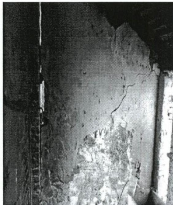
j) As paredes de alvenaria possuíam significativas rachaduras e o reboco já envelhecido caia até mesmo ao ser tocado;
