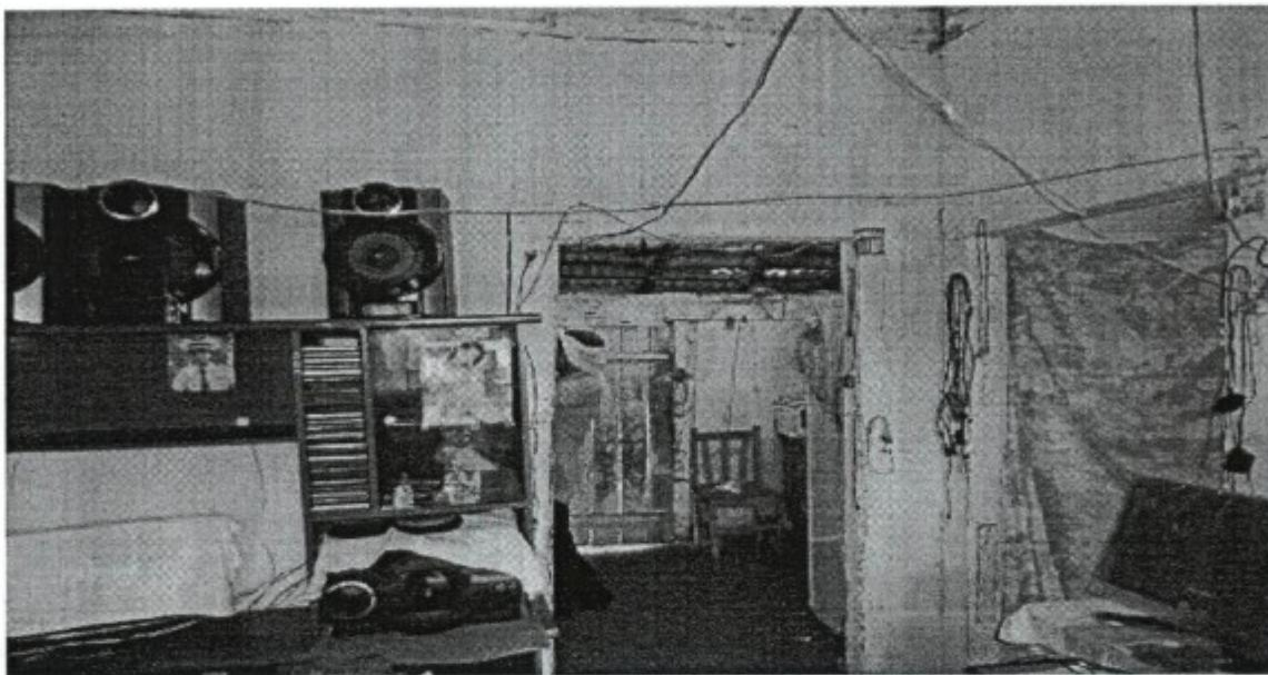
c) A parte elétrica era construída por fios soltos pela estrutura de madeira de sustentação da cobertura e pelas paredes da moradia, com ligações de aparelhos elétricos realizados em fios desencapados. Os fios expostos quando isolados eram feitos com amarras de plásticos cortadas de sacolas de supermercado;
