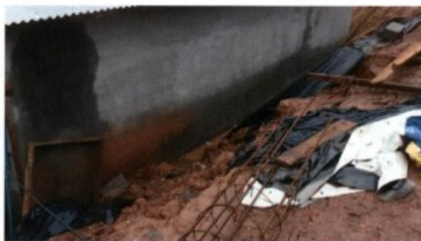
Desmoronamento sobre parede do vestiário.
