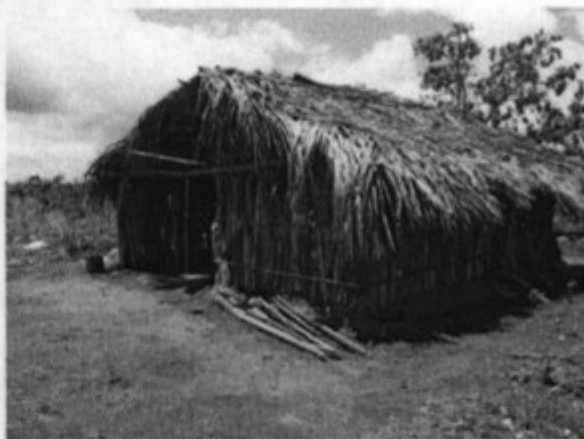
Barraco A, construído de palha de buriti e madeira do cerrado. Cômodo utilizado como cozinha.
