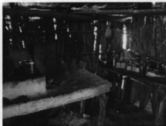
Barraco A, construído de palha de buriti e madeira do cerrado. Cômodo utilizado como cozinha.
