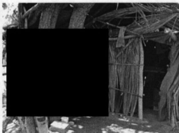
Barraco F, construído de palha de buriti, madeira do cerrado e lona plástica.
