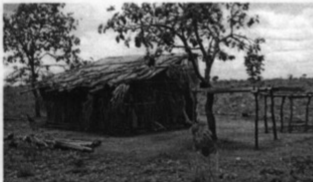
Barraco C, construído de palha de buriti, madeira do cerrado e lona plástica. Improvisação de fogão.
