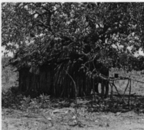
Barraco F, construído de palha de buriti, madeira do cerrado e lona plástica.
