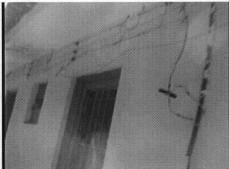
Foto 10 : Instalações elétricas precárias.
