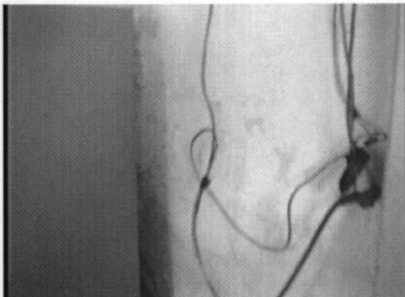
Foto 11 : Instalações elétricas precárias.
